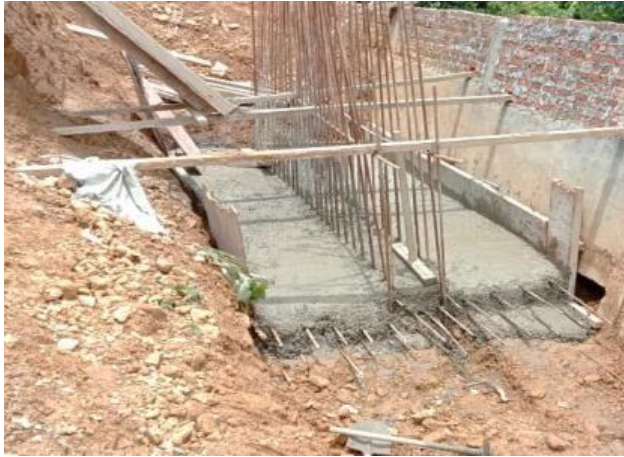
RCC retaining wall at 33/11 kV S. Bungtlang
